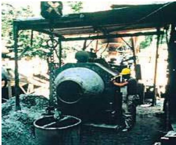
Per caricarla, stando a fianco della betoniera in moto, si deve portare di slancio il badile carico fino alla sua bocca. Di fronte ad essa bisogna fermarlo di colpo e gettavi dentro il materiale.
